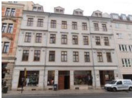
Dresden - Bautzner Straße 46
